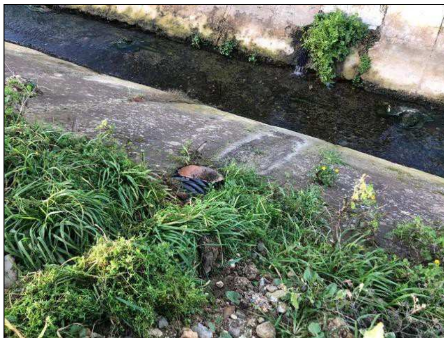
Figura 4.2/V: Scarico acque meteoriche nel canale di guardia
