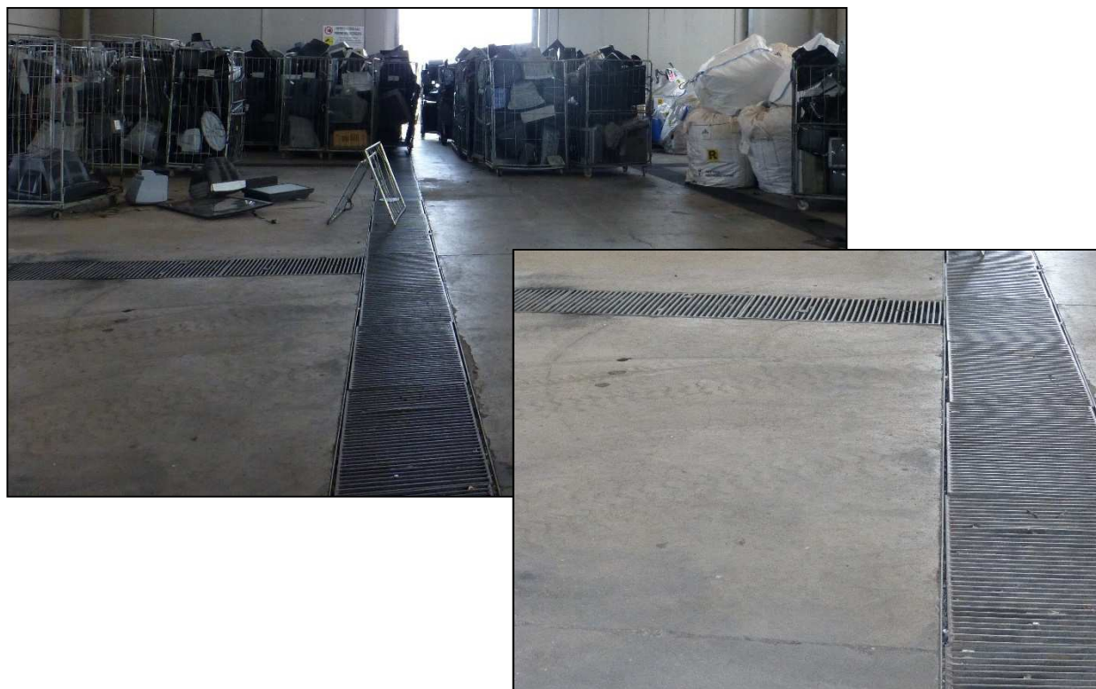
Figura 4.2/IX: Canalette grigliate a pavimento
