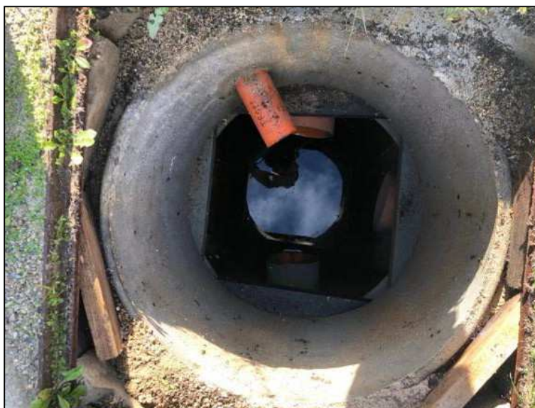
Figura 4.2/III: Vista interna del pozzetto scolmatore
